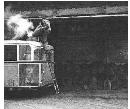
Das Holz wird von oben hineingeschüttet. Unten wird die Asche und Schlacke wie bei einem Ofen herausgescharrt. (Foto: zvg)
