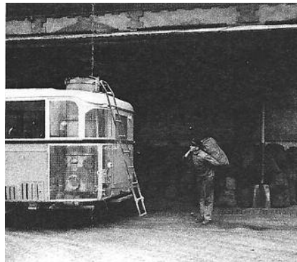
Ein Chauffeur buckelt einen Sack voll Holz-scheite. Nachschub, um den Holzvergaser zu füllen.
