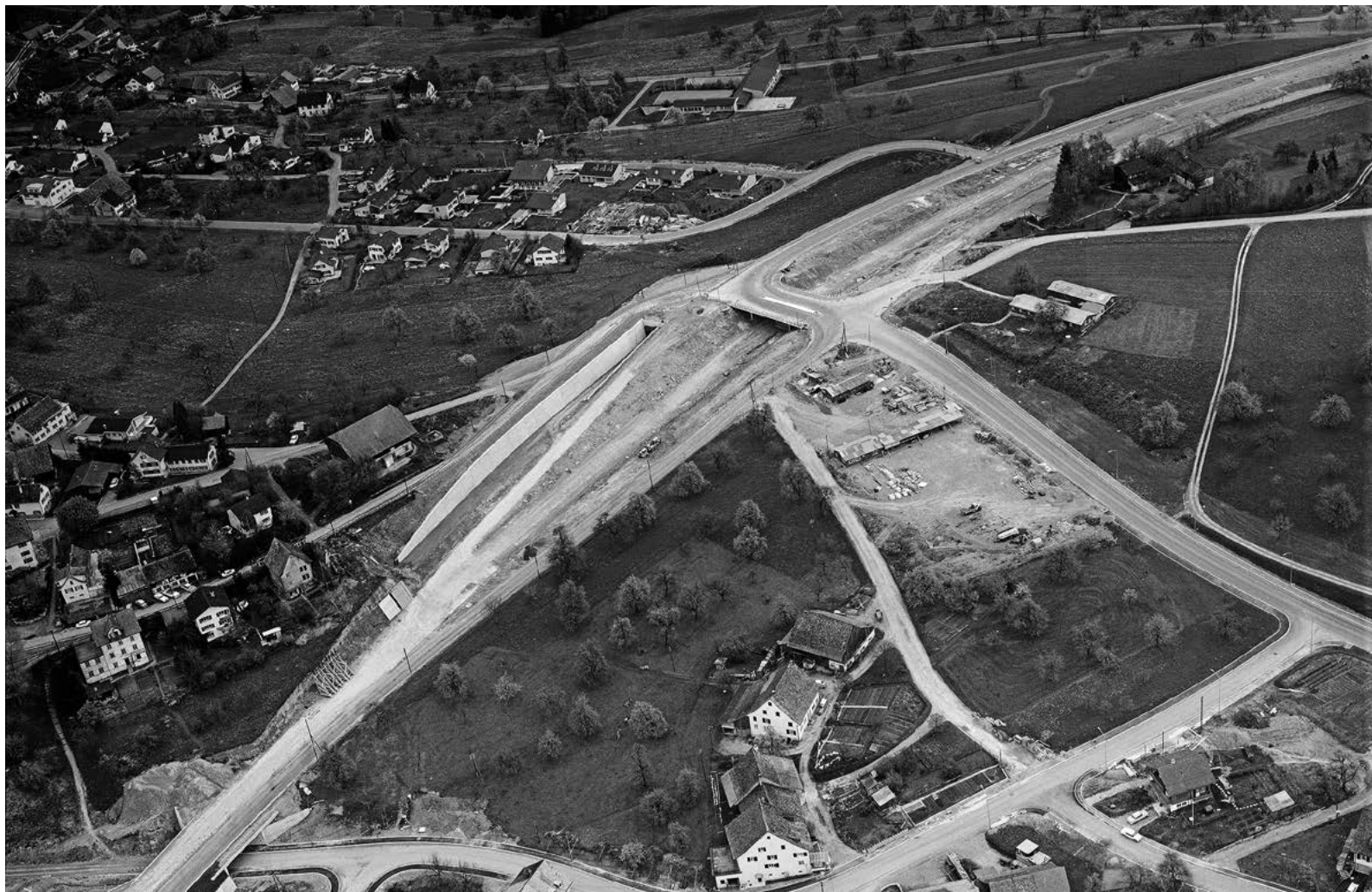
Das Luftbild von 1963 zeigt die Forchstrasse im Bau. Schon erstellt ist die Brücke, erkennbar auch die neue Führung der Forchbahn. Im Hintergrund das noch wenig bebaute Quartier Maiacher mit dem Schulhaus Aesch.
