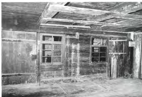
Dachgeschoss. Diele, Verbretterung gegen Kernbau (1626) und Eingang Dachkammer
