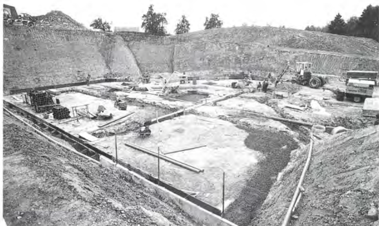
Noch leere Baugrube...
