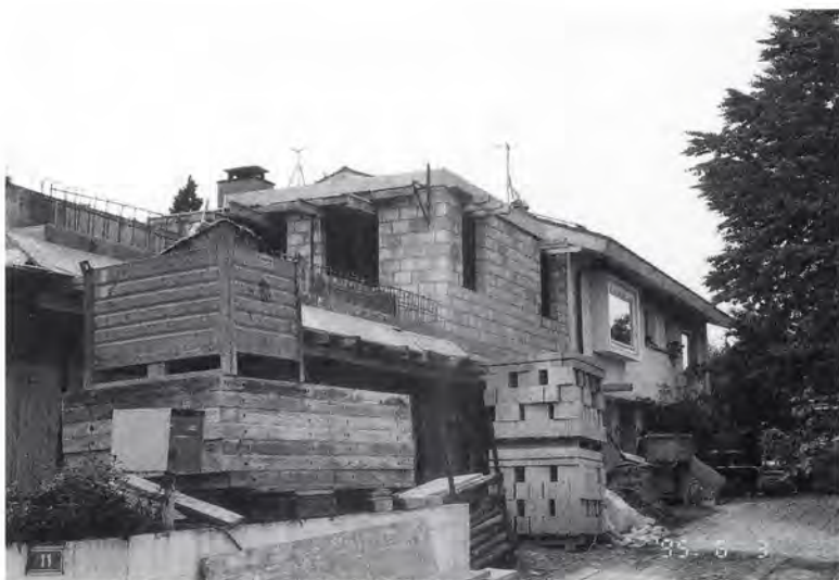
Anbau eines Einfamilienhauses an ein bestehendes Gebäude.
