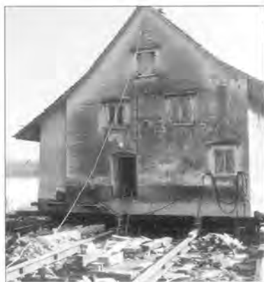
Februar 1981 - gerade wurde Trudy Stolls Haus, Letzi 48, auf Schienen gehoben. In etwa zwei Stunden wird es am neuen Standort landen.
