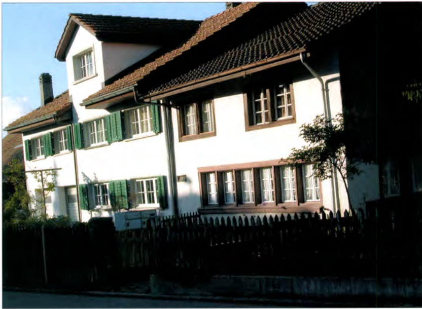
2004: Die Vorderseite der auf dem oberen Bild als Rückseite zu sehenden angebaute Flarzhäusergruppe – nun teilweise modernisiert – von der Hans-Roelli-Strasse her.
