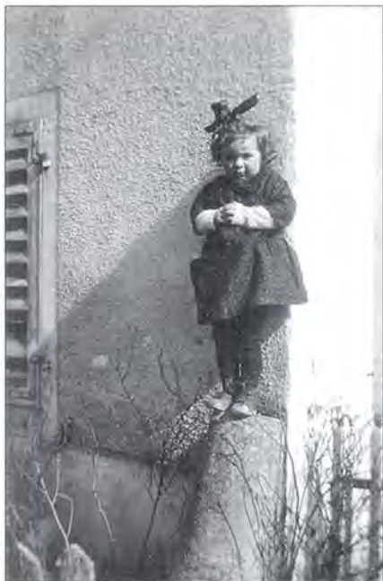
Elisabeth Fenner-Roth als kleines Mädchen auf dem Prellstein an der strassenseitigen Wand des Fennerhauses, Ende der 1920er Jahre. Der Prellstein (er steht heute noch) sollte verhindern, dass Räder vorbeifahrender Fuhrwerke die Hauswand beschädigten (Foto: Privatbesitz Elisabeth Fenner-Roth)
