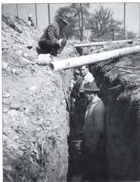
Wasserleitungsbau von Maur nach Aschbach 1956.
