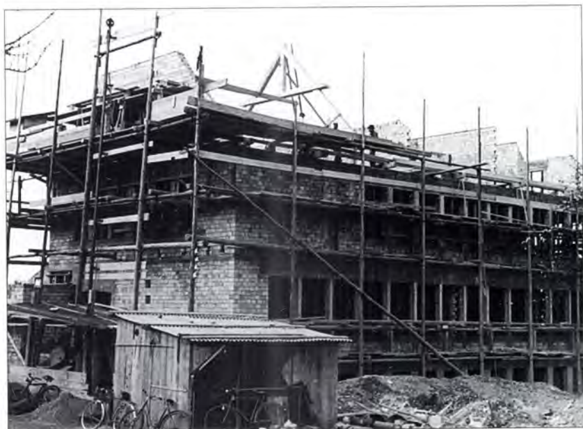
Schulhaus Pünt 1941, Gerüst mit Bauaufzug links.
