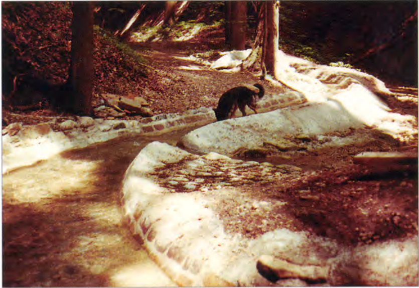
Rex war Hans Müllers treuer Begleiter während der Sanierungsarbeiten beim Waldweiher und bei der Befestigung des Hangs. Hier wird das Überlaufwasser in feste Bahnen gelenkt. Vom Waldweiher aus stürzt sich das Wasser 26 Meter tief hinab zur Turbine. (Foto: Privatbesitz Hans Müller)
