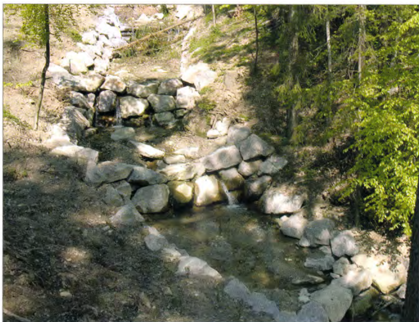
Der Dorfbach zwischen Aeschholz-, Eggenberg- und Tobelstrasse: Eine Landschaftsgärtneri hat das Wasser mit natürlichen Verbauungen in seine Bahn gelenkt.
