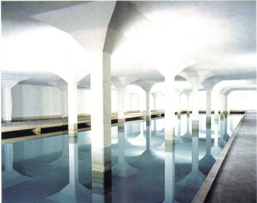
SWW Lengg, einer der 13 Langsamfilter.
