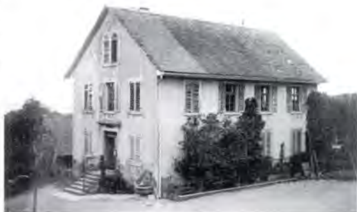
Altes Schulhaus Aesch, erbaut 1841. Aufnahme vom 2. Juni 1913, kurz vor der Renovation. Heute Kindergarten.
