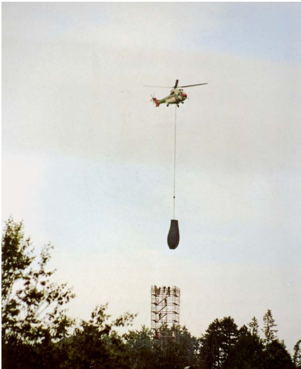
Der fliegende Baukran mit dem bauchigen Bodenstück.
