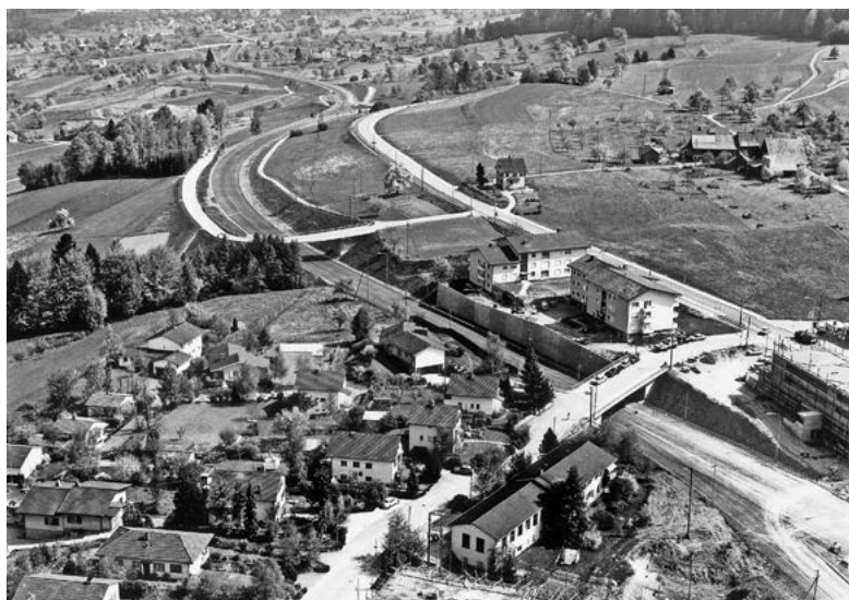
Im Frühjahr 1971 konzentrierten sich die Bauarbeiten um die Autobahn. Das «Grütli» ist 1970 den Wohnblöcken gewichen, die neue Station ist im Bau und die Tägerstrasse wird verdichtet; die heutige Höhenstrasse ist erst eine Verbindungsstrasse zwischen Forchmer und Scheuremer Dorfstrasse. Bild: unbekannt
